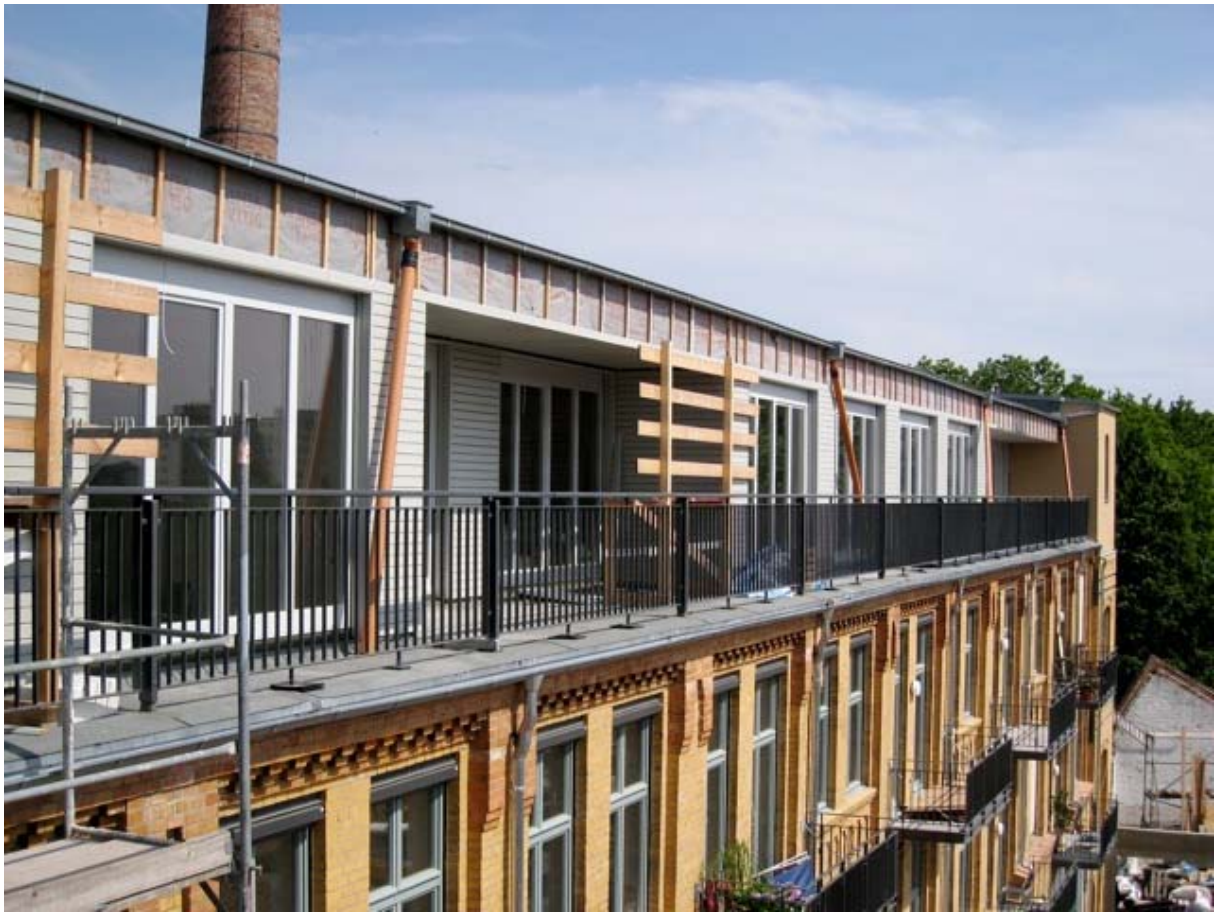
Fabrik 2. Bauabschnitt - Restarbeiten an den Fassaden im Penthouse
