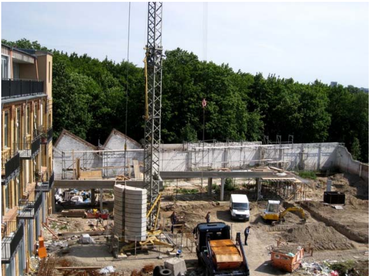
3. Bauabschnitt – Weiterbau an der Garage + Sicherung Friedhofsmauer zum 3. BA + Gründungsarbeiten für Apartmenthaus Südwest
