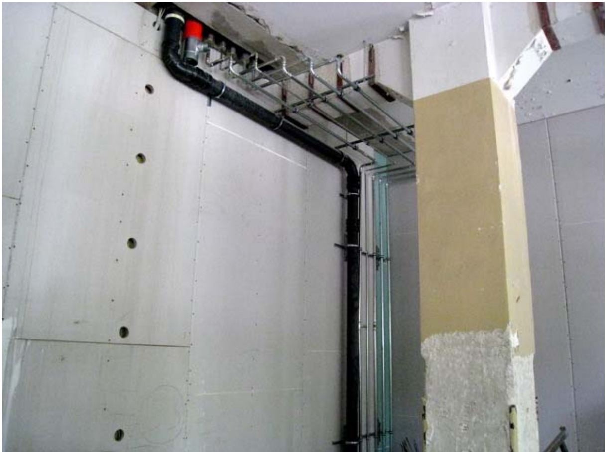
Kontorhaus – Innenausbau + Rohinstallation
