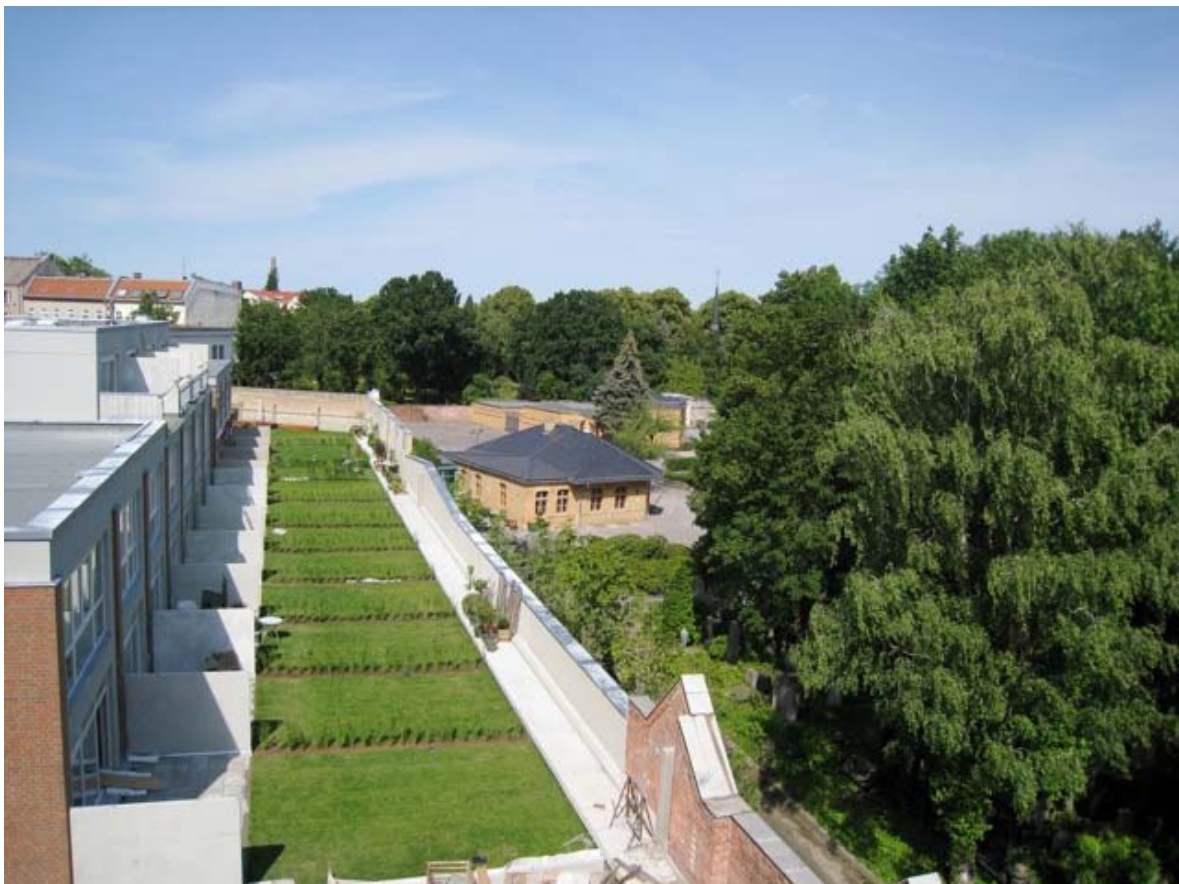
Fertigstellung der Gärten Townhouses 1. BA + Rollrasen + Hecken + Fertigstellung Friedhofsmauer
