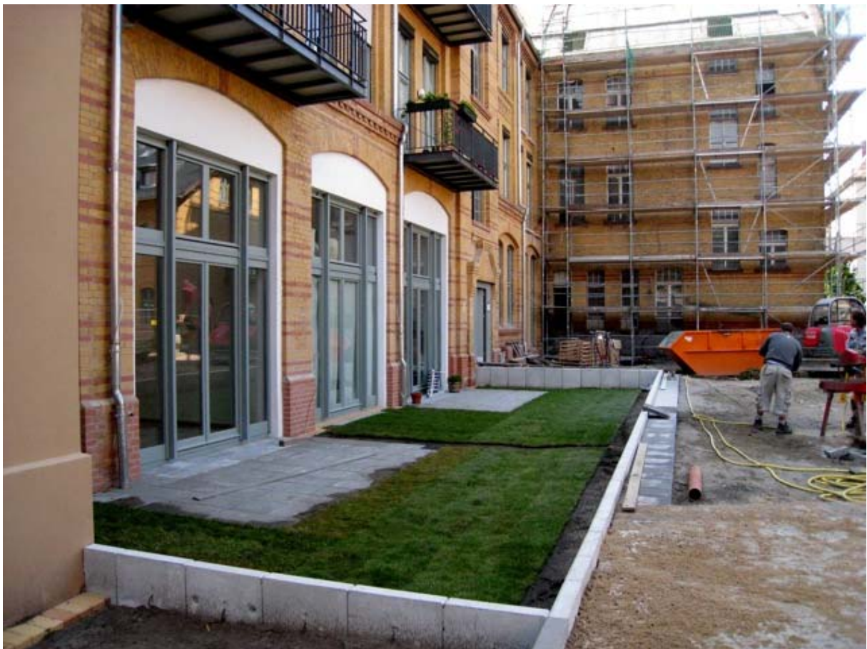
Fabrik – Anlegen der Terrassen und Gärten zur Ostseite
